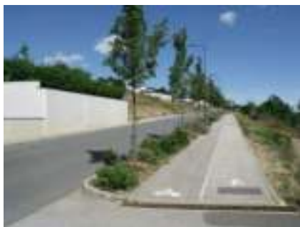
Cheminement doux avenue Nelson Mandela
