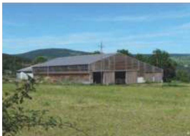
Hangar agricole traité avec un bardage bois en harmonie avec le paysage
