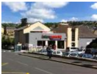
Supermarché à proximité immédiate du centre ville.
