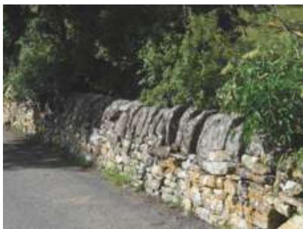
Détail de l’appareillage d’un muret en pierres
