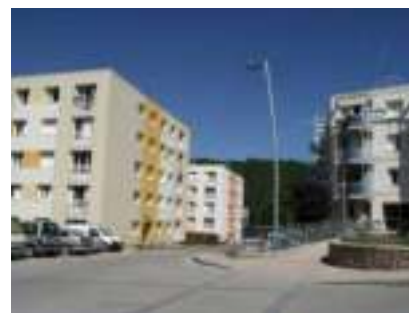
Parc de logements aidés des années 1970, dans le quartier de Fontanilles
