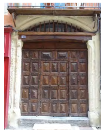
Rue d'Aigues-Passes. Vantaux en pointes de diamant.
