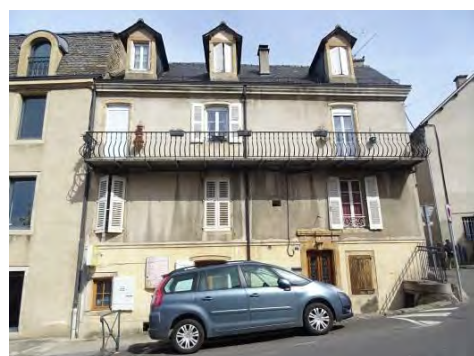
Rue des Ecoles. 19e siècle. Lucarnes en pierre.
