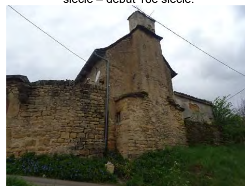
Chanteruéjols, maison des 15e – 16e siècles ? Mur pignon avec cheminée monumentale et son conduit.
