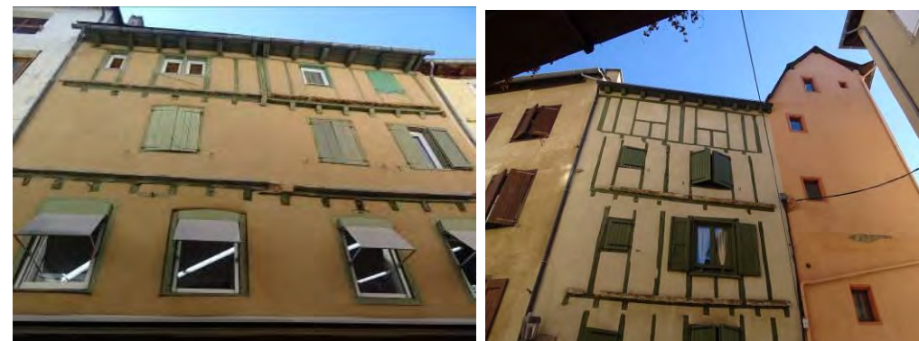
Rue de la Liberté. A droite, rue d'Angiran. Façades des 15e16e siècles remaniées au 18e siècle.
