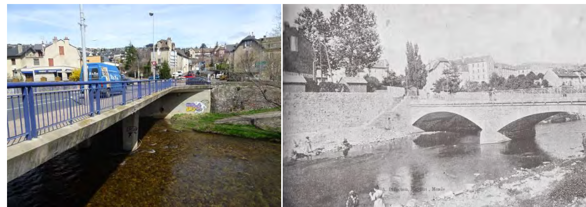
Le pont de Berlière. Reconstitué en 1870, il fut détruit en 1973 pour être une nouvelle fois rebâti plus large. A droite, le pont sous sa forme XIXe siècle (carte postale vers 1900).
