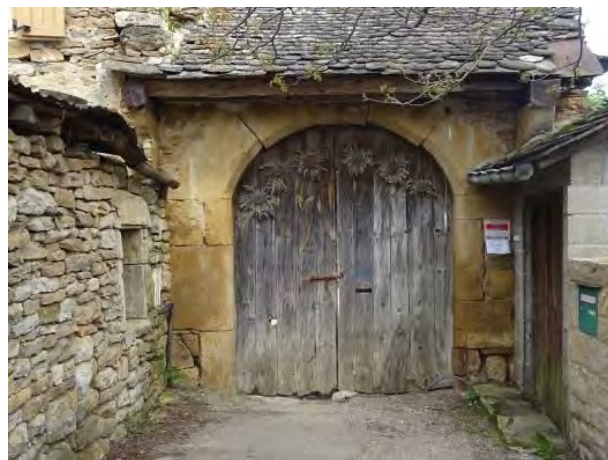
Chabannes. Porche sous couverture de lauzes.
