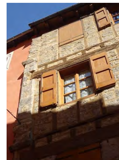
Rue d'Angiran. Façade des 15e – 16e siècles dont le pan de bois en encorbellement (présence du refend) a été mis en recul ultérieurement (17e – 18e siècles ?)
