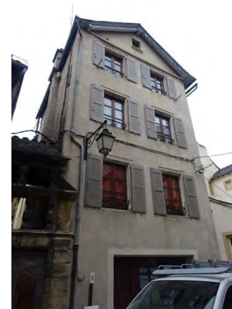
Rue de la Jarretière. Maison des 15e – 16e siècles remaniée au 19e siècle.
