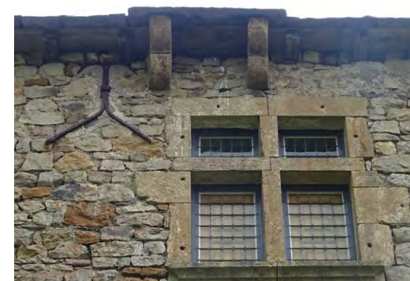
Bahours, maison forte du 17e siècle (classé MH). Façade ouest.
