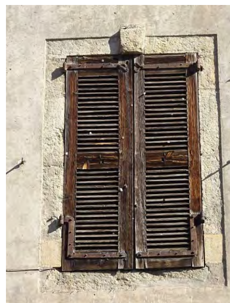
Rue d'Angiran. Fenêtre du 19e siècle et ses persiennes en bois.
