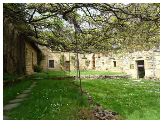
Chabrits, logis de la seconde moitié du 15e siècle – début 16e siècle complété de deux ailes autour d'un jardin.
