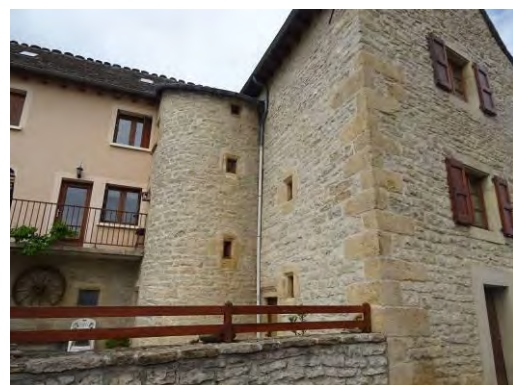
Chabannes, repaire de la seconde moitié du 15e siècle – début 16e siècle. La tour d'escalier en vis est placée hors œuvre.
