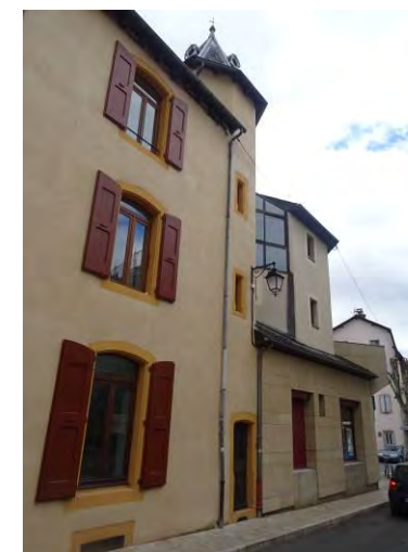
Rue Chaptal. Tour d'escalier dans l'œuvre. 15 e – 16 e siècles.
