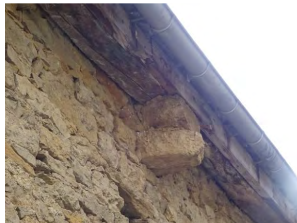
Chabrits, grange-étable. Sablière de rive et corbeaux en pierre.
