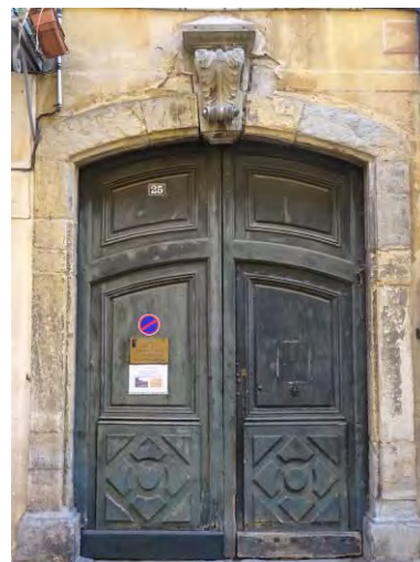
Rue Basse. Portail du 18e siècle.
