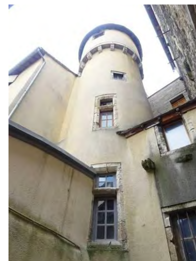
Rue d'Aigues-Passe. Tour d'escalier semi hors-œuvre.
