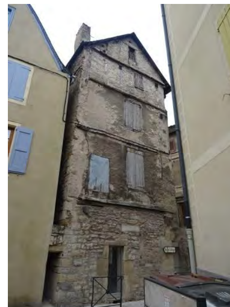
Rue du Collège. Façade pignon de la seconde moitié du 15e siècle – début 16e siècle.
