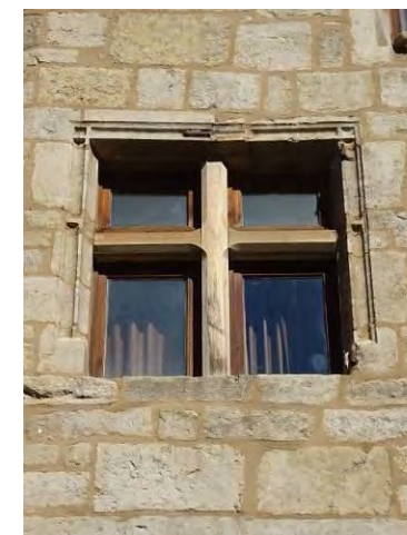
Rue de l'Ancienne Maison consulaire. Fenêtre à meneau à moulures croisées Seconde moitié 15e siècle – début 16e siècle. Le meneau et les croisillons disparus ont été remplacés par des éléments en bois.
