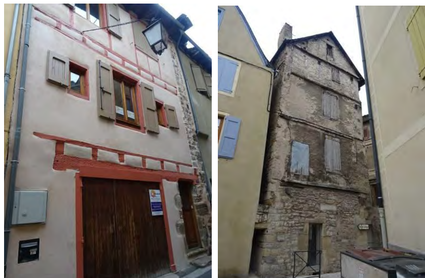
Rue des Finets. 15 e – 16 e siècles. Le pan de bois des étages, à l'origine en encorbellement, a été disposé dans le plan du rez-de-chaussée. A droite, maison rue du Collège. Façade pignon de la seconde moitié du 15 e siècle – début 16 e siècle.
