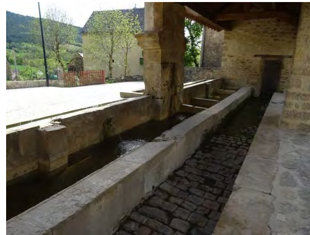
Chabrits, le lavoir de 1879. Vue des bassins
