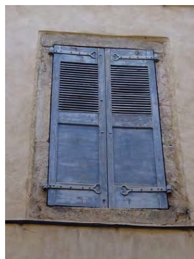
Rue Basse. Fenêtre du 19e siècle.
