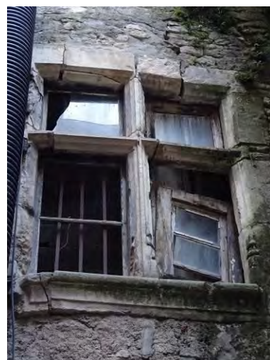
Rue d'Angiran. Fenêtre à meneau. Seconde moitié du 15e siècle – début 16e siècle. Façade sur cour.
