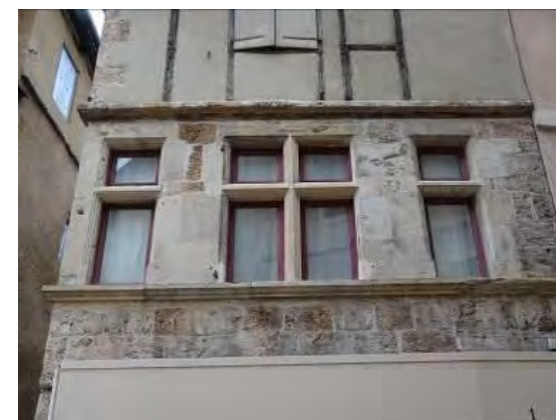
Rue du Chastel. Fenêtre à meneau et fenêtres à traverse du 16e siècle soulignées d'un cordon d'appui mouluré.
