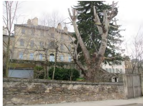
Boulevard Lucien Arnault. Mur de clôture d'un hôtel particulier du 18e siècle de la rue Basse.
