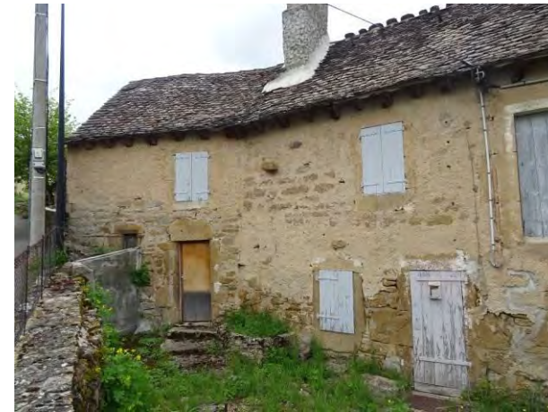
Chanteruéjols. Couverture à deux pans en lauzes de schiste.
