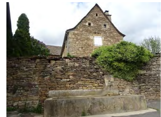
Chabannes. Murs d'enclos en pierre.
