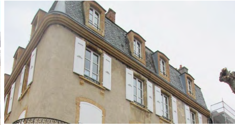
Boulevard Henri Bourrillon. Corniche en pierre moulurée. 19e siècle.
