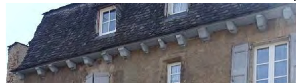
Rue d'Angiran. 15e – 16e siècles. Abouts de solives d'avant-toit profilés de chanfreins et de congés en cuiller.
