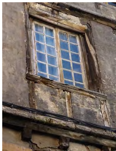
Rue de l'Epine. Menuiseries à petits carreaux adaptées à une fenêtre à meneau après disparition de la division initiale en bois.
