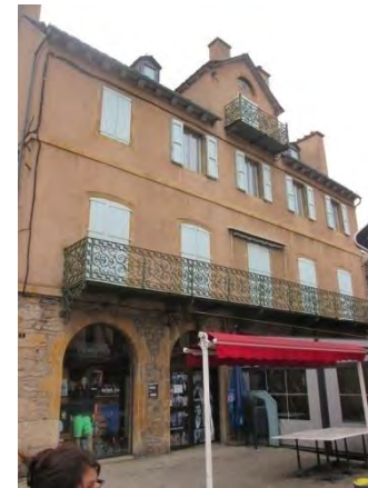
Boulevard du Soubeyran, garde-corps du 19e siècle.
